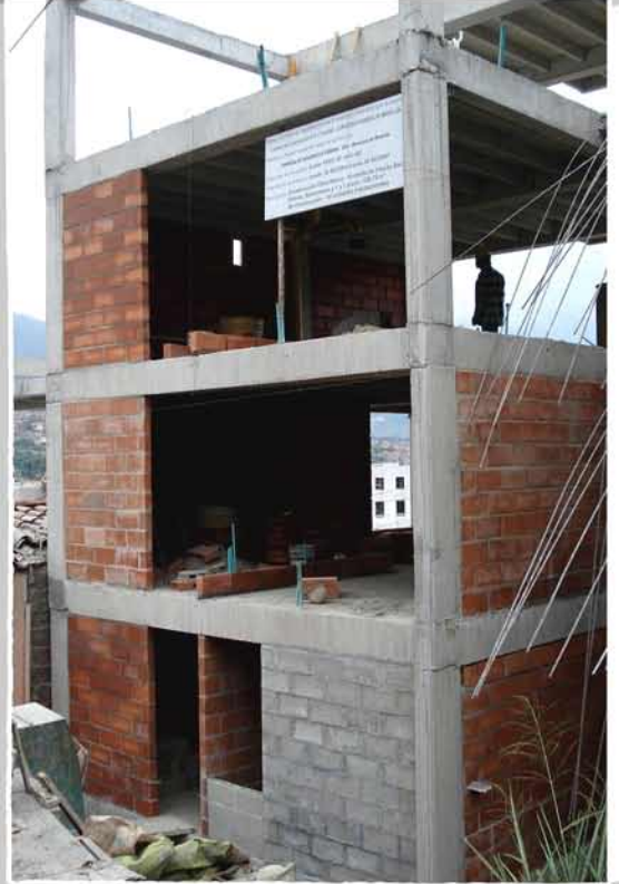
Quebrada Juan Bobo, Villa Niza - Construcción
