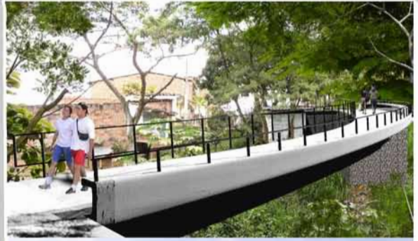
Puente Villa del Socorro - Andalucía - Después
